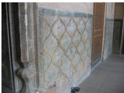
تصویر ۷: لایه‌چینی روی ازاره سنگی ایوان چهلستون
